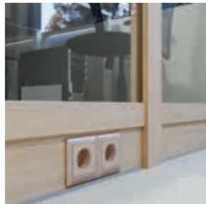
Плинтус в шпоне позволяет нивелировать неровность пола.
